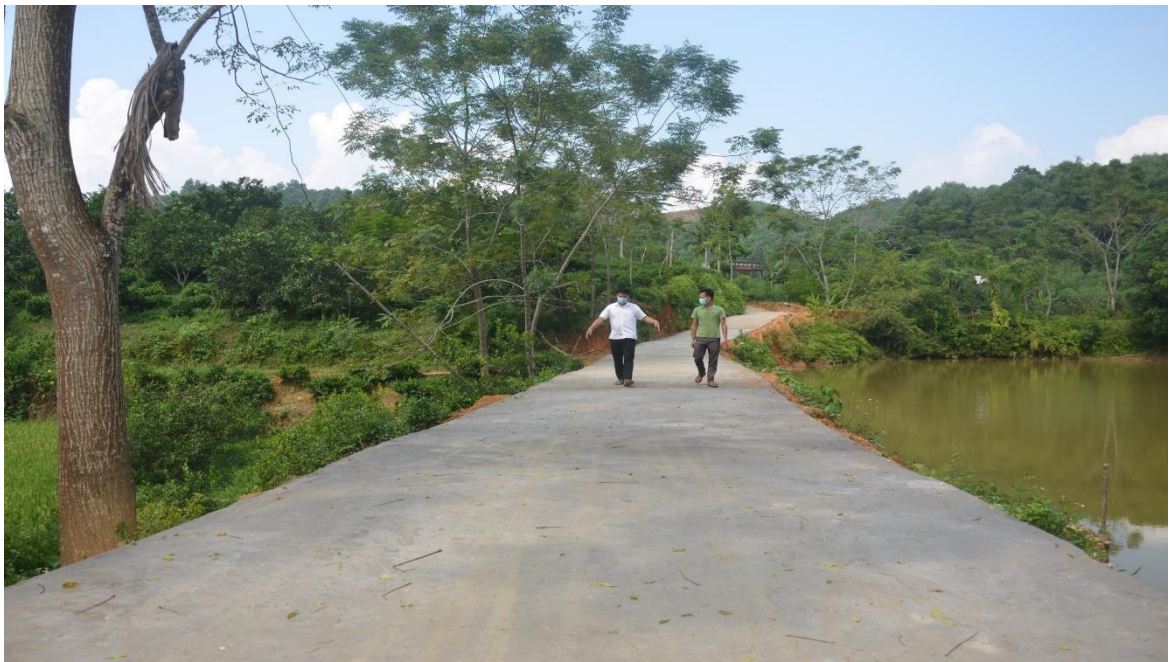
Đường thôn Việt Thành 2, xã Tân Thành (Hàm Yên) đổ bê tông theo phương châm “Nhân dân làm, Nhà nước hỗ trợ”
